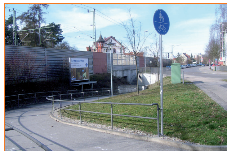
Bahnunterführung in der Frühlingstraße
